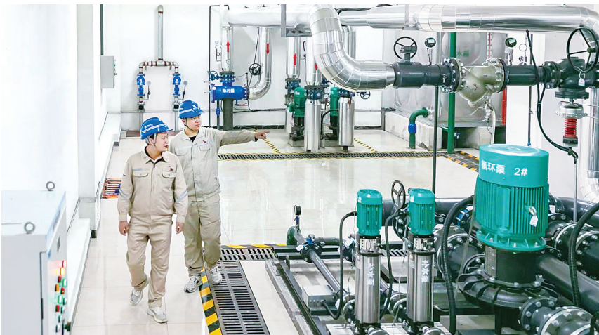
工作人员在换热站进行检修工作。 保定市城市管理综合行政执法局供图
