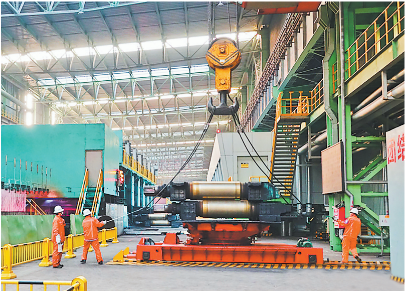
唐山东华钢铁热连轧车间工作人员在更换轧辊。
