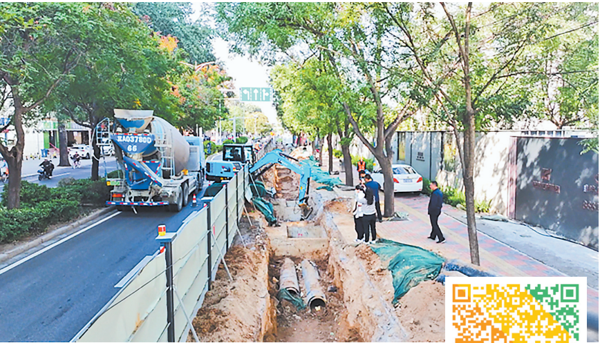
石家庄市建华大街与跃进路交口供热管网改造工程施工现场。
