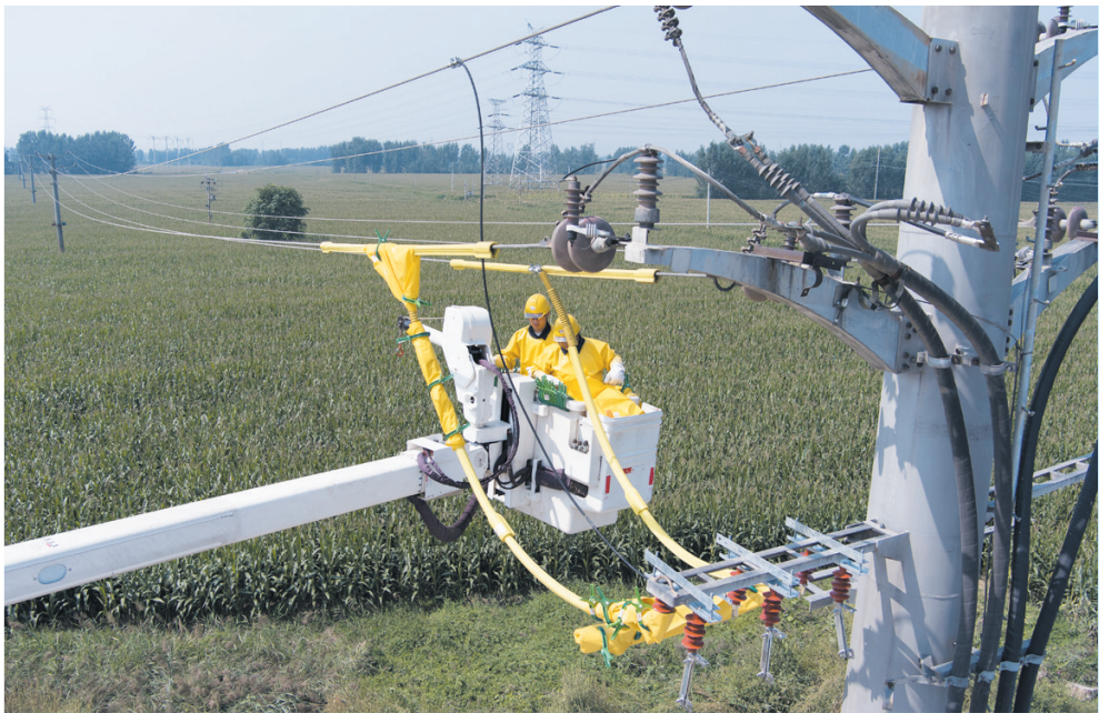
近日,霸州供电公司开展带电作业专项岗位练兵活动,紧扣秋季电网检修保供工作重点,以标准化、实战化实训模式锤炼一线作业队伍专业能力,全面夯实秋检安全生产根基,为公司秋季电网检修、可靠供电保障工作筑牢人才与技术支撑。 刘岩 摄
