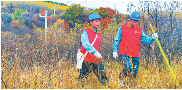
9月29日,围场供电公司塞罕坝共产党员服务队队员开展10千伏羊场512线路巡检,排查消除隐患,护航国庆节线路稳定运行。 刘春学 摄
