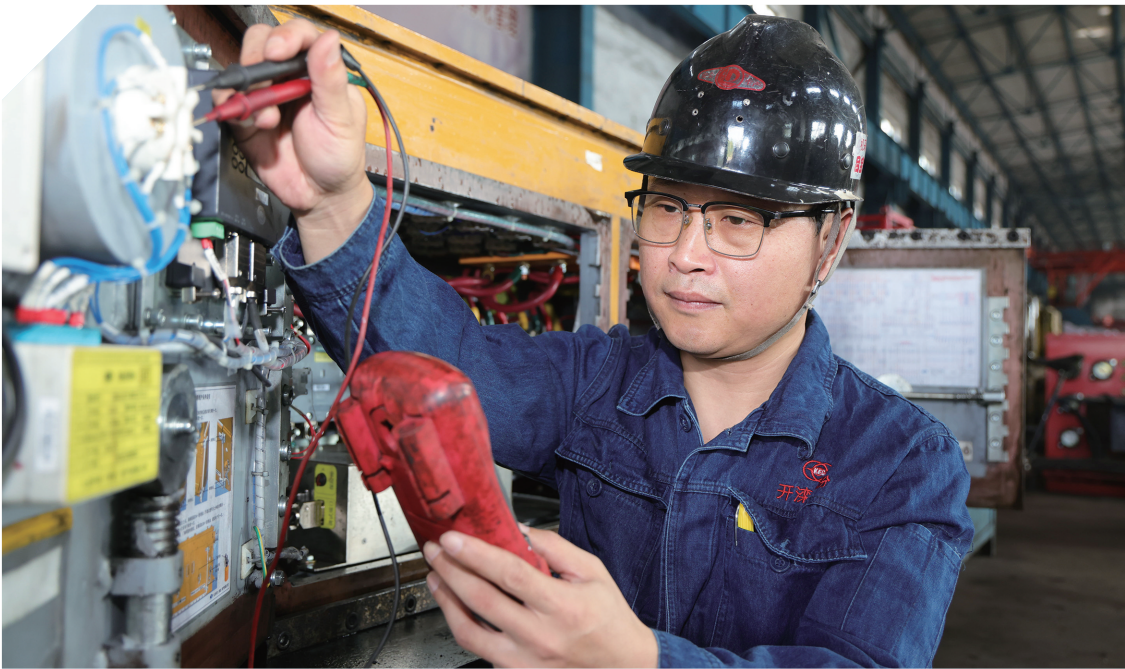
开滦股份吕家坨矿秉持“精检细修 匠心服务”工作理念,组织技术骨干围绕设备“零缺陷 零延误”主动发力,将检修责任落实到日常工作每一环,为安全高效生产保驾护航。图为该矿电工高级技师在检修掘锚一体机电控箱。
