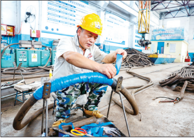
今年以来,开滦股份范各庄矿深入推进修旧利废工作,通过旧品修复再利用、盘活闲置物资等实现节支降耗,助力企业降本增效。图为开滦股份范各庄矿机采科员工正在修补旧电缆。 闫丽颖 崔奕 摄
