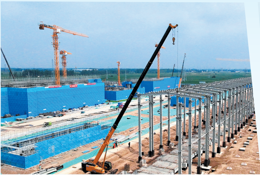
雄南±800千伏换流站工程500千伏GIS室钢结构吊装。
