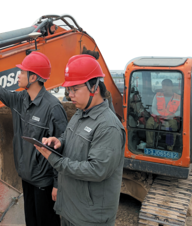
施工机械搭载易挖宝智能引导系统。
