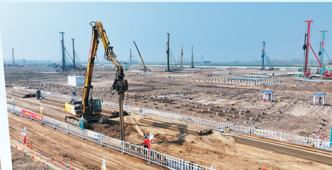
雄南±800千伏换流站工程进行雨污水钢板桩作业。
