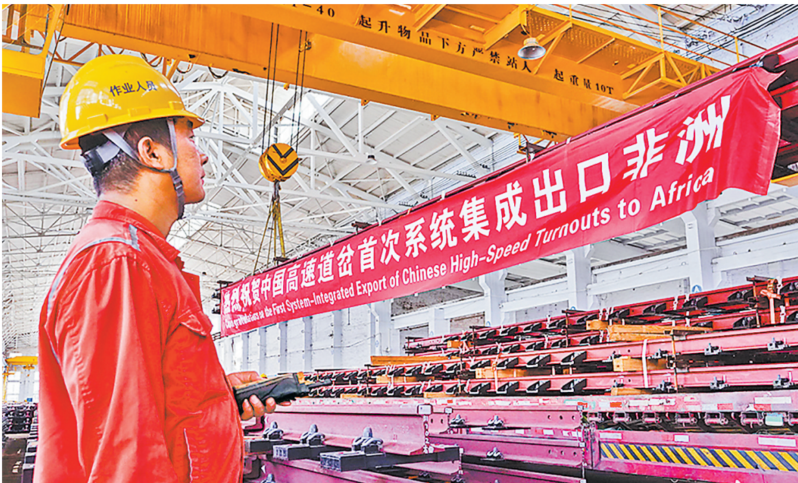
工人操控天车进行吊装工作。
