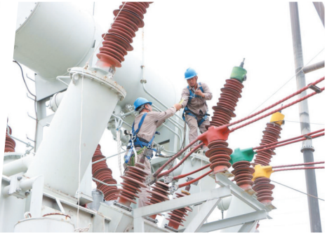
作业人员正在对220千伏侯坊站2号主变110千伏侧套管采样。 全云涛 摄
