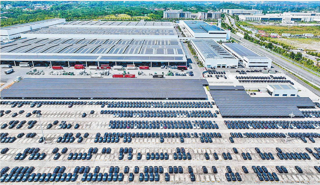
这是七月十六日在重庆市沙坪坝区拍摄的赛力斯超级工厂（凤凰）（无人机照片）。新华社记者 王全超 摄
