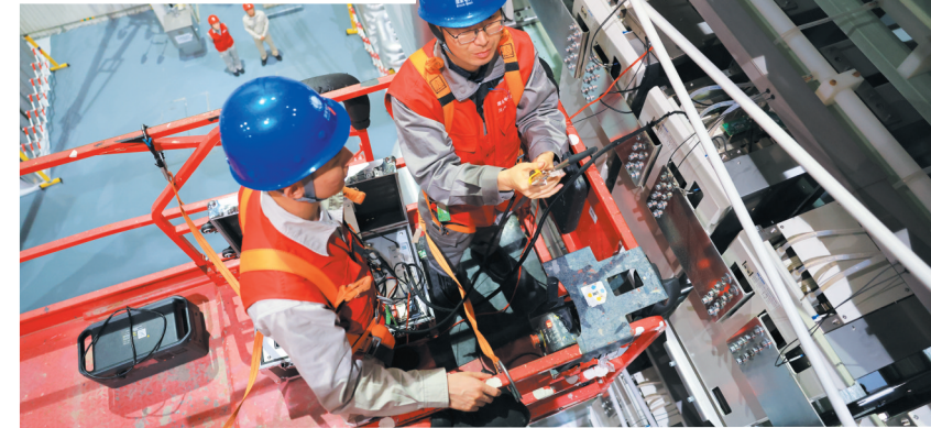
国网冀北电力检修人员在中都换流站铁塔上进行现场检测。赵勇 摄
