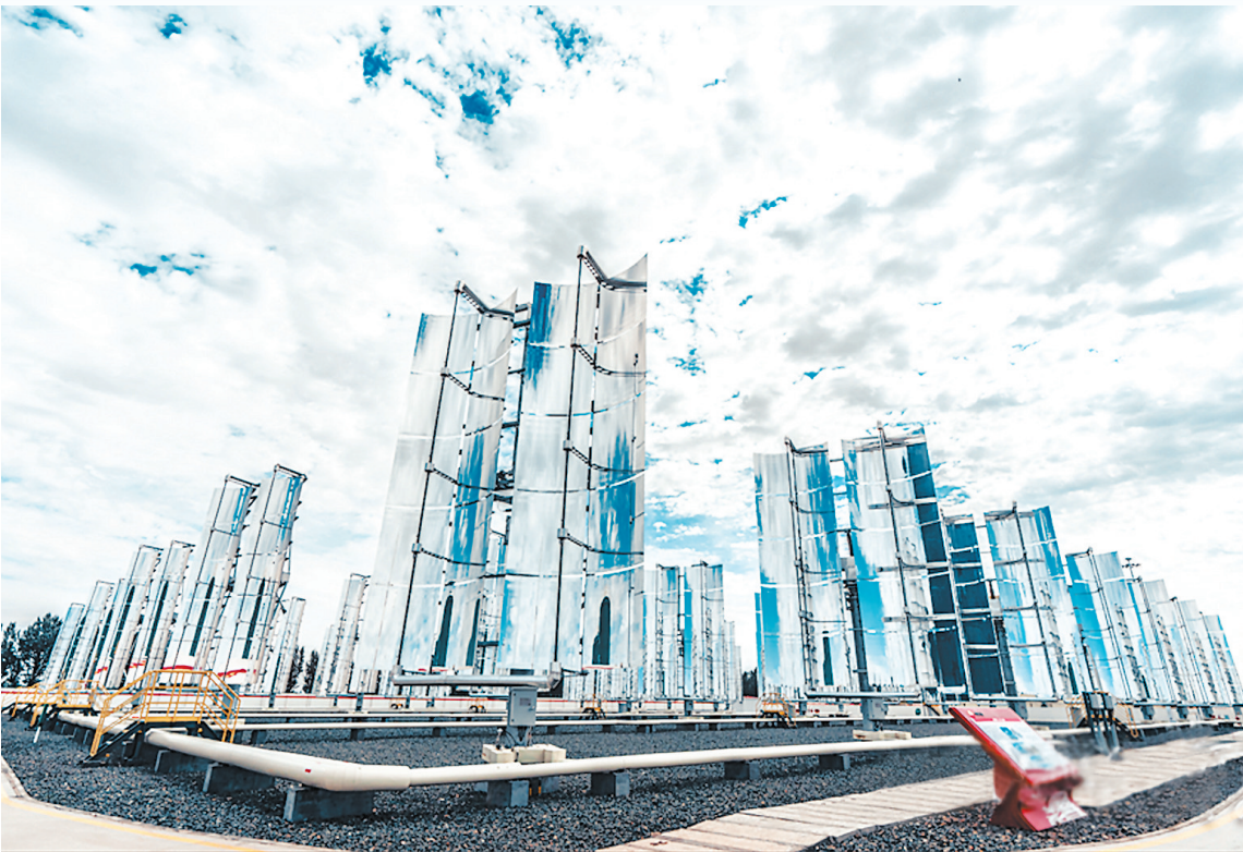
华北油田在内蒙古自治区建成国内最大双轴双槽集热系统。王立强 摄
