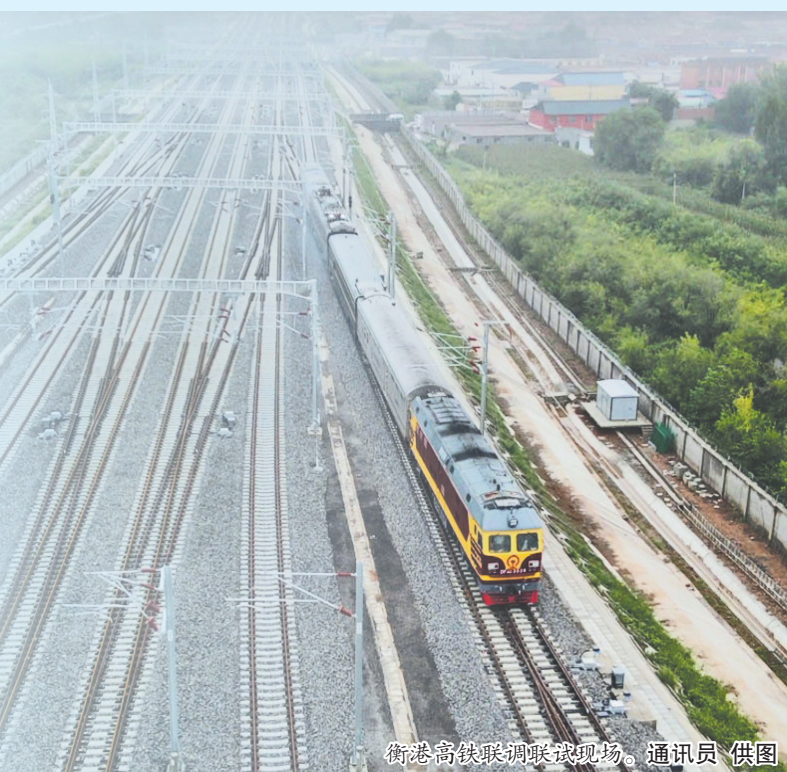
衡港高铁联调联试现场。通讯员 供图
