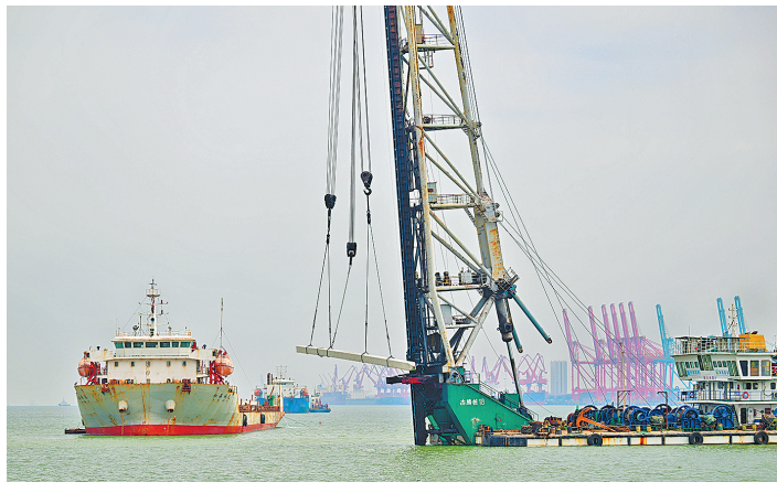
8月19日拍摄的黄骅港综合港区滚装码头一期工程项目施工现场。该工程总投资16.2亿元,规划建设1个5万总吨客货滚装泊位、1个7万总吨汽车滚装泊位。项目建成投运后,码头年通过能力可达商品汽车28万辆、滚装车辆9万辆、杂货22万吨,大幅提升港区滚装运输承载能力。 新华社发(冯奕超摄)
