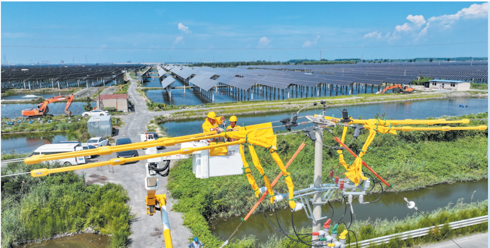
8月4日上午,唐山供电公司不停电作业中心员工来到唐山市曹妃甸区五农场,为35千伏五场变电站10千伏五南线522干线69号杆带负荷加装柱上开关,保障迎峰度夏期间养殖户用电。 周宇翔 摄
