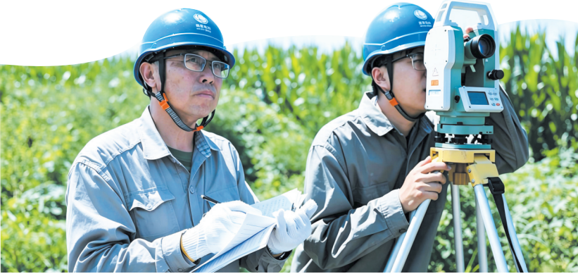
8月6日,张家口供电公司输电运检中心运维人员运用经纬仪对“三跨”区段开展对地距离实测。 苗双林 摄
