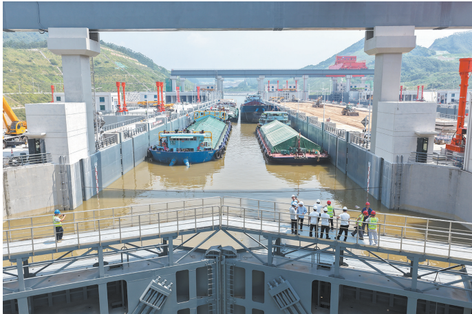
8月12日，试验船舶驶进平陆运河马道枢纽船闸（无人机照片）。
