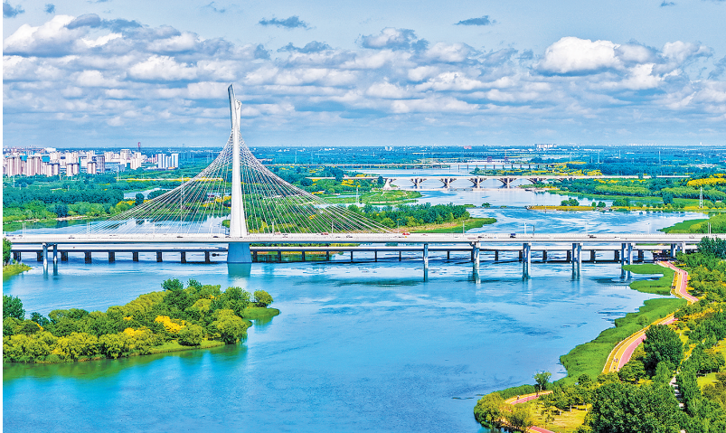
5月22日拍摄的石家庄市复兴大街滹沱河大桥。 新华社发(张晓峰摄)
