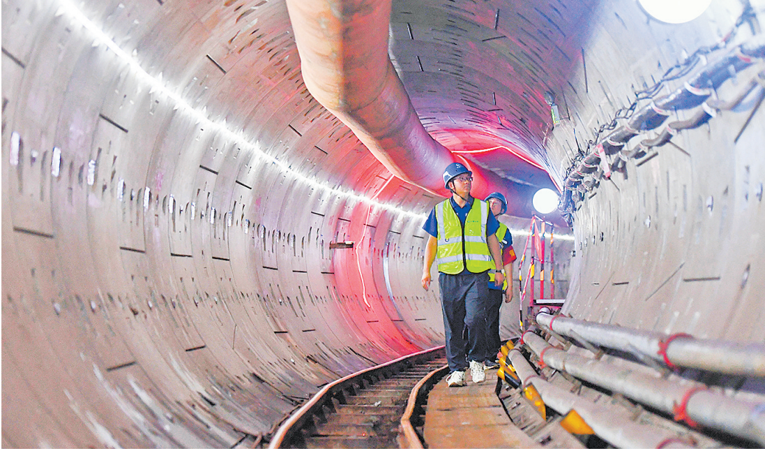
2024年1月21日，天津市滨海新区雨污分流改造工程项目雨水主管隧道顺利贯通，工作人员在雨水主管隧道内检查盾构管片。
