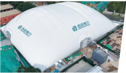
6月26日,国网河北电力首个“基坑气膜”在保定西大园110千伏变电站新建工程项目正式投用。
