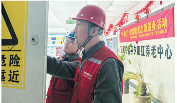
8月4日,巨鹿供电公司组织党员服务队走进官亭镇养老院,开展“寸草心”爱老敬老志愿服务活动。队员们对养老院电力线路设备、插座、电器等逐一排查检修,现场讲解安全用电知识,用暖心行动为老人送去关怀与温暖。
