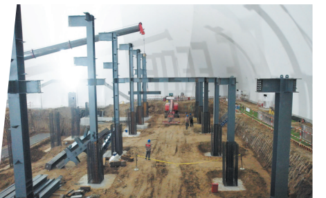
7月21日,保定西大园110千伏变电站新建工程气膜作业现场,正在开展钢架结构吊装施工作业。
