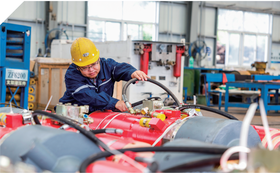
今年以来,开滦集团唐山矿业公司做实做细采煤机、掘进机、泵站“三大件”和单轨吊等大型设备日常维护,确保检修质量过硬,最大限度降低机电故障对安全生产的影响。图为该公司检修人员在核对液压设备。 崔奕 郝壮 摄
