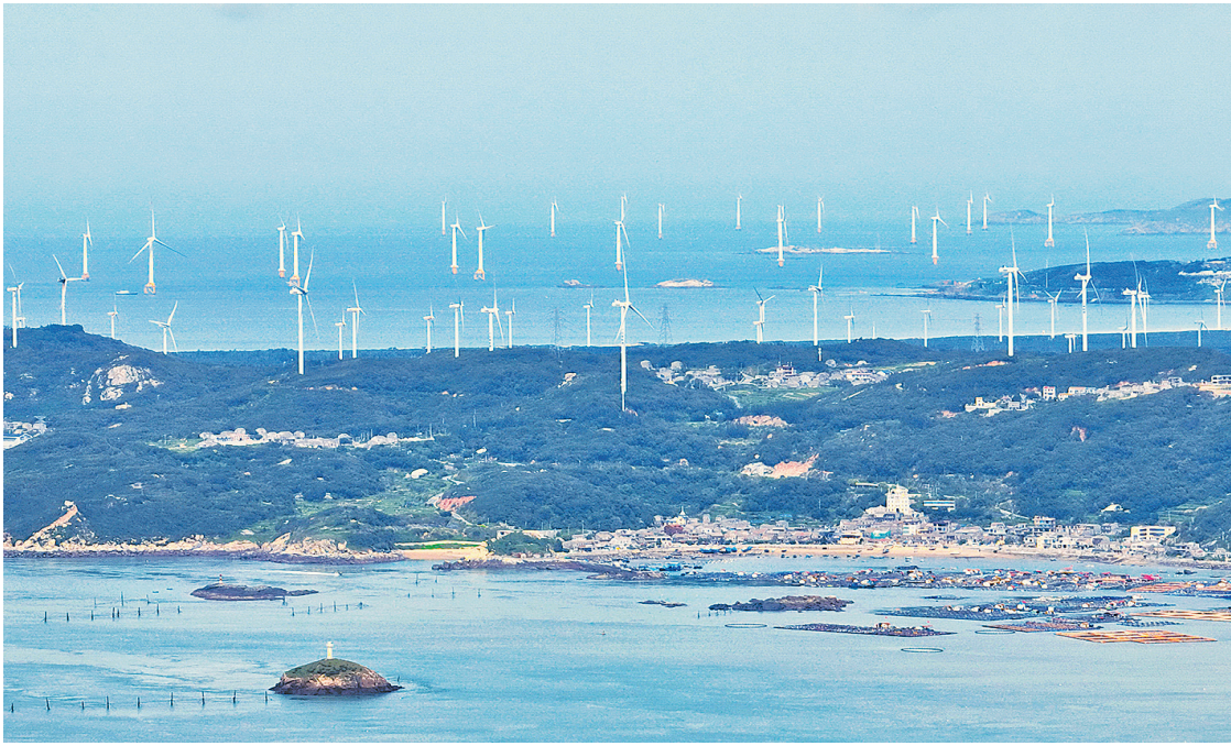
照片。在福建平潭海域拍摄的海上风电场和陆上风电场(无人机拍摄)。 新华社记者 林善传 摄
