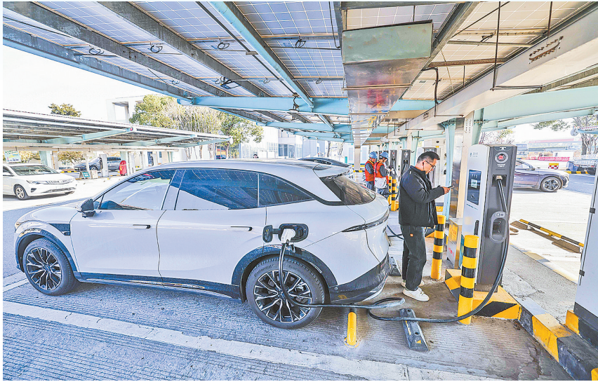
在高速服务区,新能源车主使用充电桩给车充电。 新华社记者 徐昱 摄
