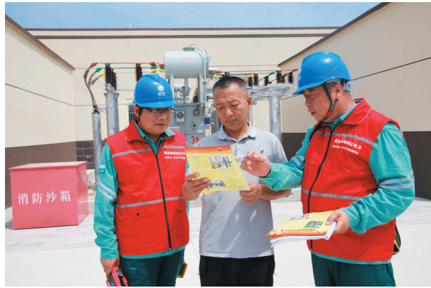
高阳供电公司持续深化党建赋能优质服务,创新推行“设备义诊全覆盖+负荷动态精控+节能定制指导”特色助企服务模式,赋能县域纺织企业高质量发展。 绳佳玥 摄
