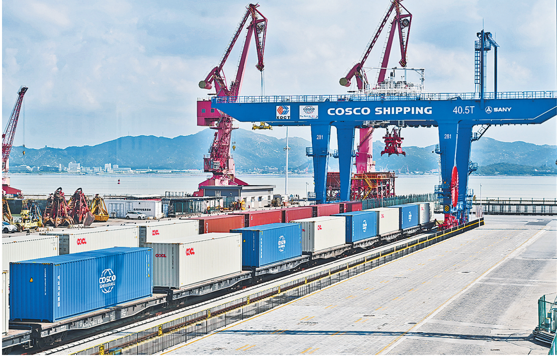
七月二十九日的厦门远海码头铁路专用线。
