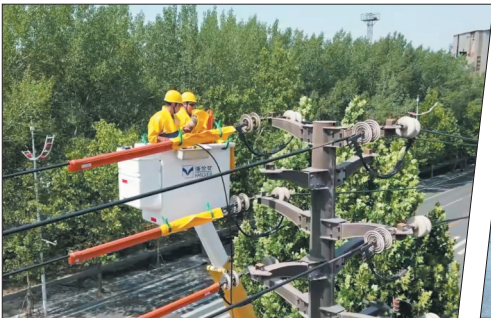
7月9日,邯郸公司带电作业人员开展消缺工作。
