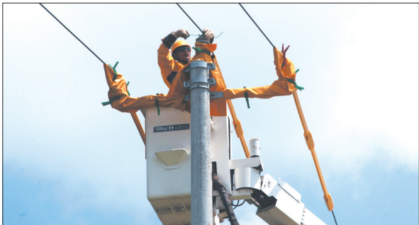
7月15日,巨鹿供电公司工作人员顶高温对10kV官亭南0623线台头支线003号杆开展带电作业,及时消除导线脱瓶安全隐患,保障群众清凉度夏。 王兴 摄
