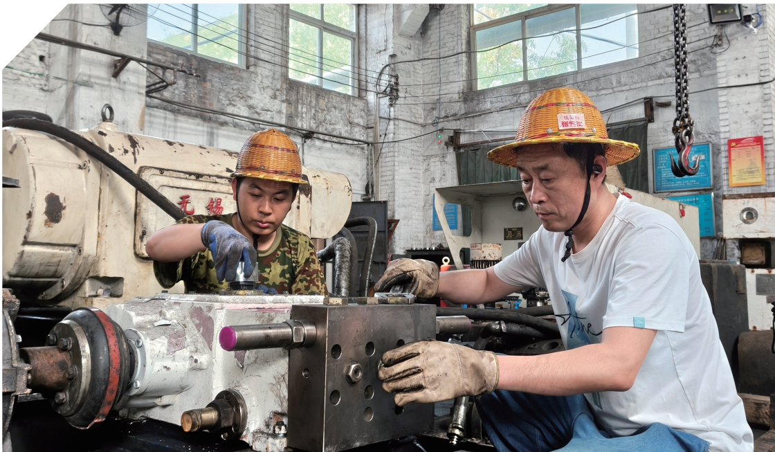
今年以來,開滦股份呂家坨礦緊盯保運轉、保銜接任務目標,抓實抓細大型設備檢修維護工作,主動“做体检”,系統“開处方”,以設備穩定運行為安全生產賦能。圖為該礦員工在檢修液泵。張婧 攝
