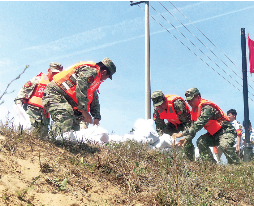
近日,威县举行 2026 年防汛抢险综合应急演练,全面检验应急队伍快速反应、协同作战与抢险救援水平,全力保障全县安全度汛。图为演练人员在加固堤坝。 本报记者 刘杨 通讯员 赵国华 摄
