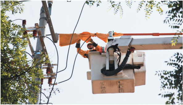
7月2日,巨鹿供电公司组织工作人员开展10千伏线路带电作业,在不停电前提下精准排查并消除线路设备安全隐患,有效保障辖区电网平稳运行与群众清凉度夏用电。王晓兴 摄
