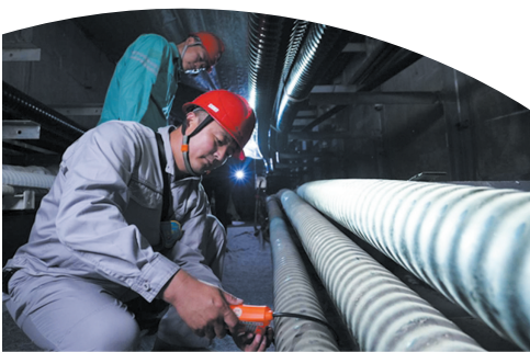
工作人员在盾构隧道对电缆进行试验检查。
