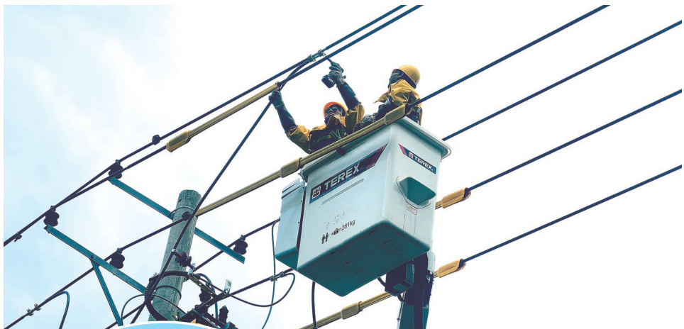
6月10日,国网高碑店市供电公司工作人员对10千伏岱岗庄537线路开展带电消缺作业。 郝嘉璐 摄
