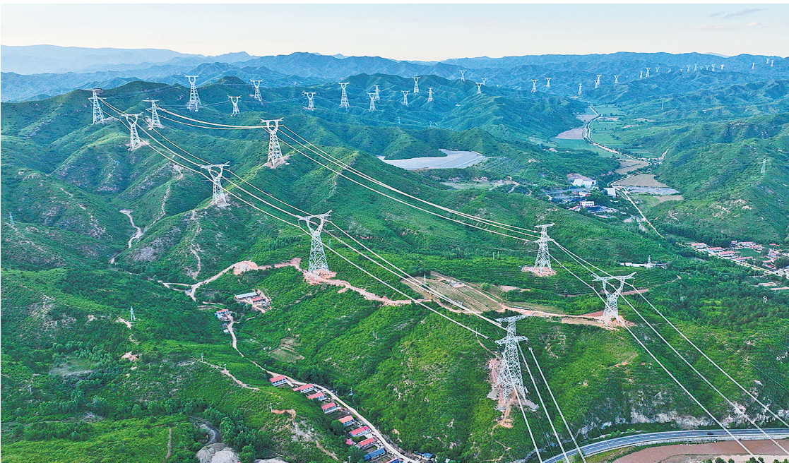
河北省承德市丰宁满族自治县境内的大同——怀来——天津南一千千伏特高压输电线路施工现场(无人机照片)。
