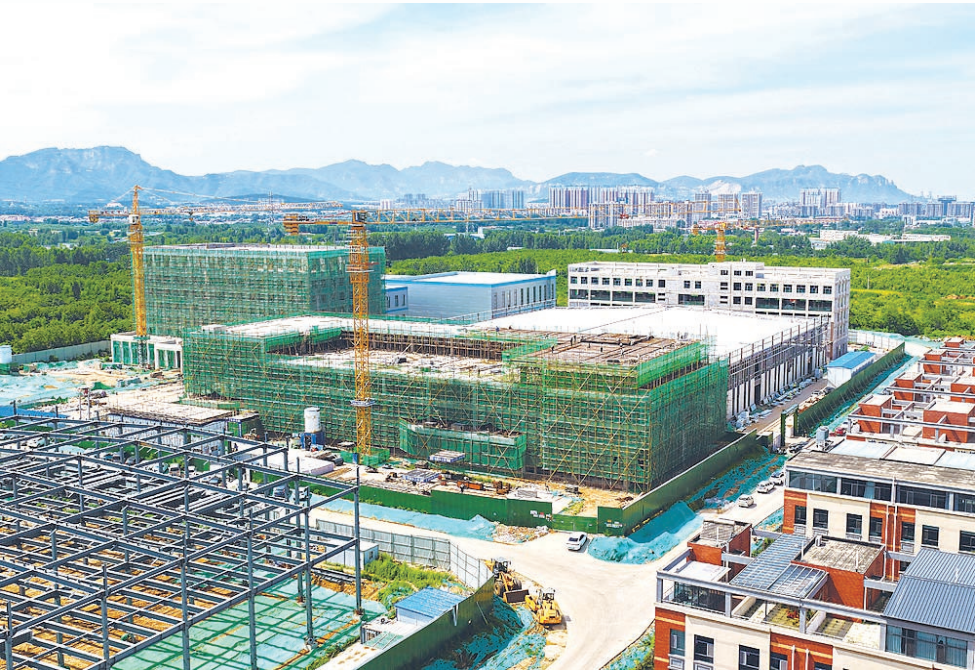
省重点项目源梦达数字设备生产基地主体建筑目前已封顶,年内即可建成投产。
