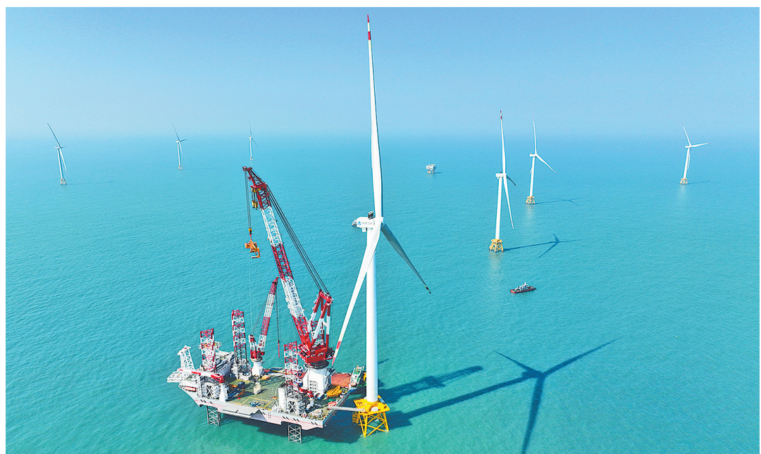
这是一月十三日在福建海域拍摄的二十兆瓦海上风电机组和“大桥海风”号两千吨自升式海上风电安装平台(无人机照片)。 新华社记者 林善传 摄
