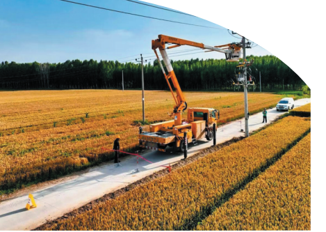
行唐供电公司带电作业人员对10千伏北庄线开展带负荷更换配电自动化开关作业。董少波 摄
