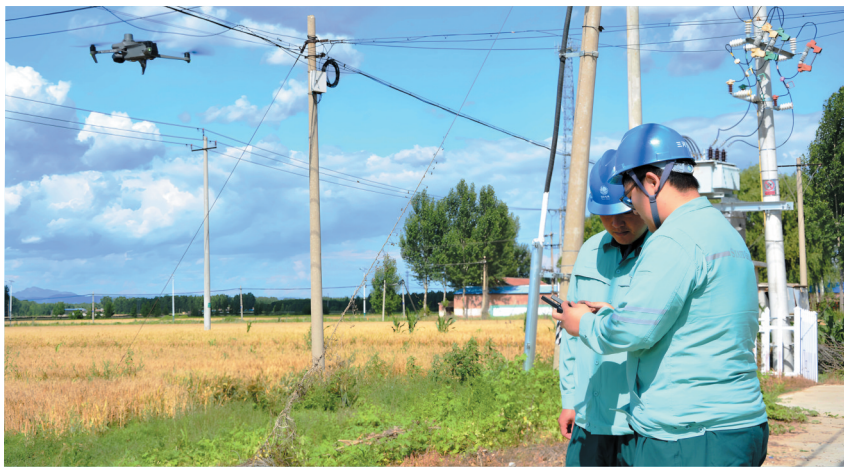
为了让农户用上“安全电、放心电”,国网三河市供电公司成立10支服务小分队,对全市10个乡镇的农排线路、台区开展拉网式巡视检查,全面更新维护电杆防撞贴、拉线保护套等安全警示标识,加密巡视频次,开展红外测温,把缺陷隐患消除在萌芽状态。(王占武 张舜 摄)
