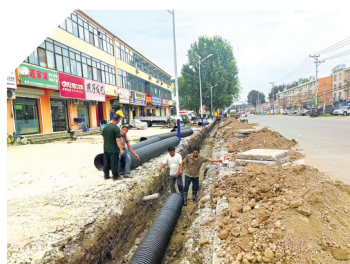
大各庄村老旧管网更换现场。闫浩帆 张莹 摄
