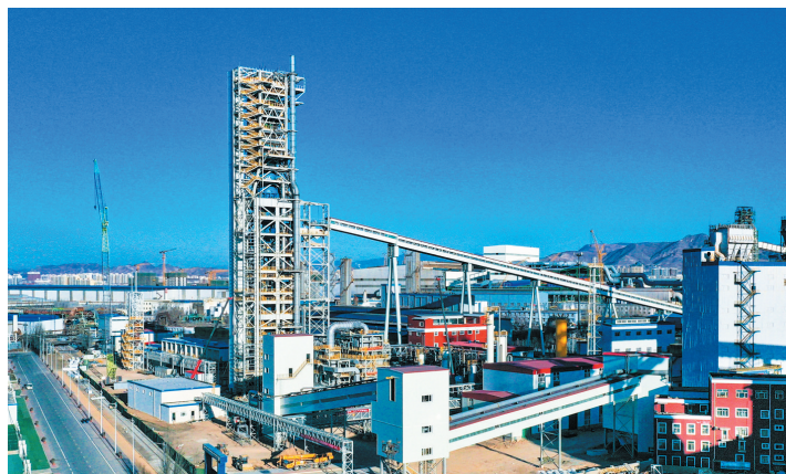
河北张宣高科科技有限公司氢能源开发和利用工程示范项目一期工程。
