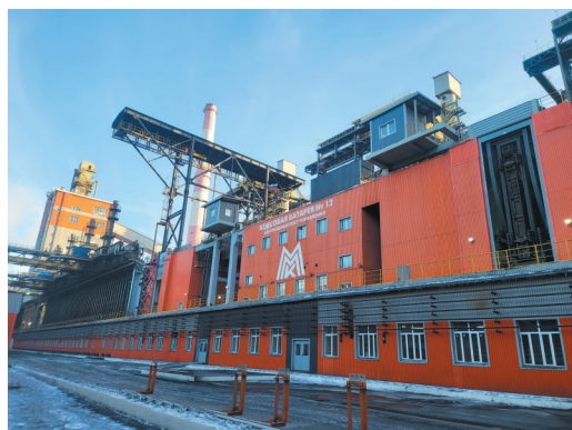
中钢设备有限公司俄罗斯MMK250万吨/年12号焦炉组项目化产安装施工。
