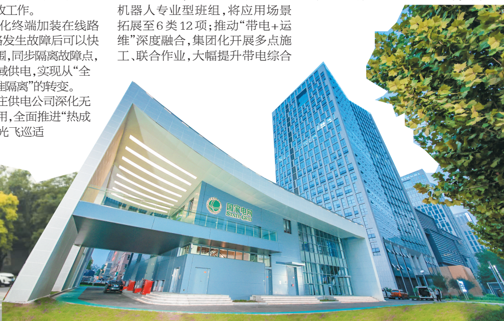
国网石家庄供电公司建成投运的110千伏裕翔城市智慧变电站。
