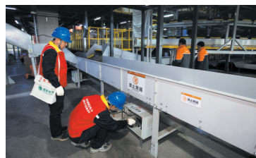
国网廊坊供电公司员工走进物流企业开展用电安全检查服务。
