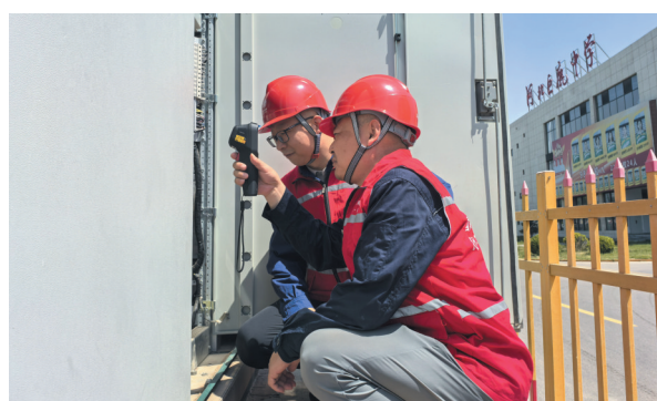
6月1日,巨鹿供电公司组织营销人员对巨鹿县一中考点的电力设备进行检查,确保高考期间稳定用电。 袁雷涛 徐光兴 摄
