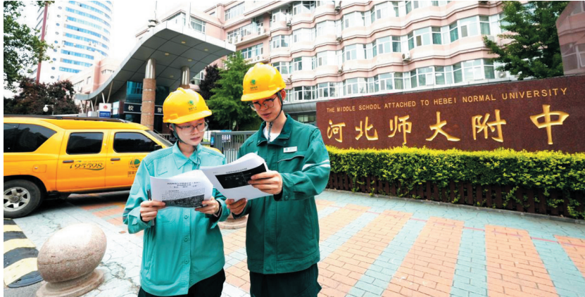
六月三日,国网石家庄供电公司桥东供电中心工作人员在河北师大附中对照专项保电方案开展特巡检查。任鹏宇 摄
