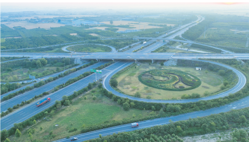
京港澳高速和保沧高速清苑段立交互通。
