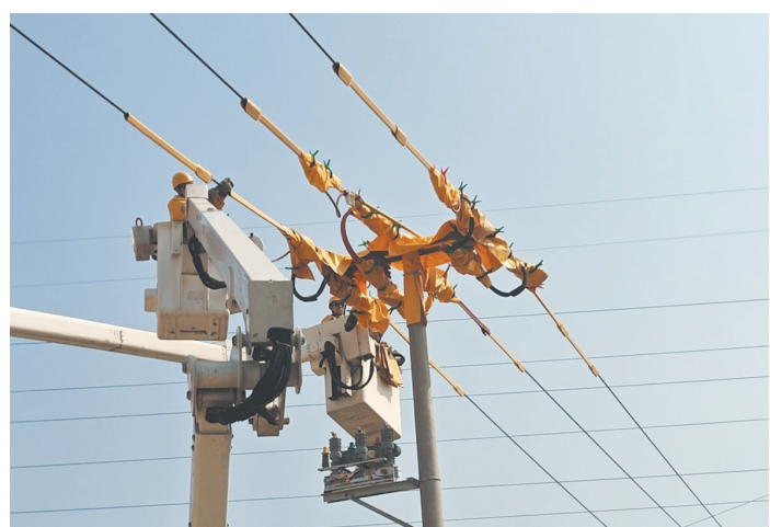
南和供电公司加快推进度夏工程建设,利用带电作业方式消除电网运行缺陷,保证迎峰度夏期间电网安全稳定运行和电力可靠供应。 刘博 成博浩 摄
