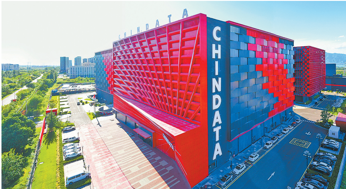
怀来大数据产业基地泰准数据中心。(受访单位供图)
