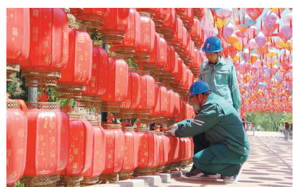
为确保景区安全可靠供电,武安供电公司组织人员深入旅游景点开展上门服务,确保景区安全用电无忧。图为该公司员工在七步沟景区开展用电安全检查。陈四海摄
