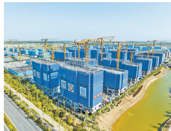
雄安新区大学城疏解配套二期项目住宅部分建设现场(5月8日摄,无人照照片)。
