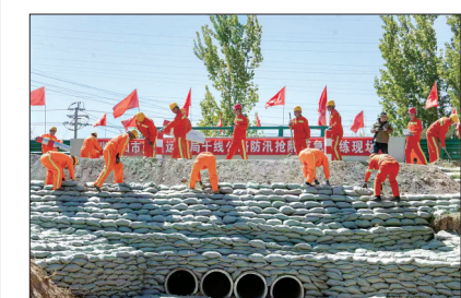
为提升干线公路防汛抢险、应急保通协同处置能力,日前,张家口市委组织开展干线公路防汛抢险应急演练,实景实战检验应急预案、锤炼抢险队伍。田宇翔 马明明 摄
