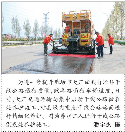
为进一步提升廊坊市大厂回族自治县干线公路通行质量,改善路面行车舒适度,日前,大厂交通运输局集中启动干线公路微表处养护施工,对县城内重点干线公路路面进行精细化养护。图为养护工人进行干线公路微表处养护施工。潘宇杰 摄
