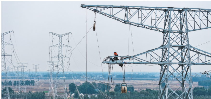
涿州500千伏输变电工程线路工程升展导线架设施工作。
