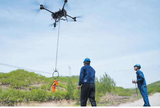
4月27日，邢台供电公司采用无人机吊装旁路电缆提升接引装置搭建旁路，配合蜈蚣梯协作方式，带电为10千伏梁家线031路加装一二次融合开关，实现山顶复杂地形下不停电作业新突破。
