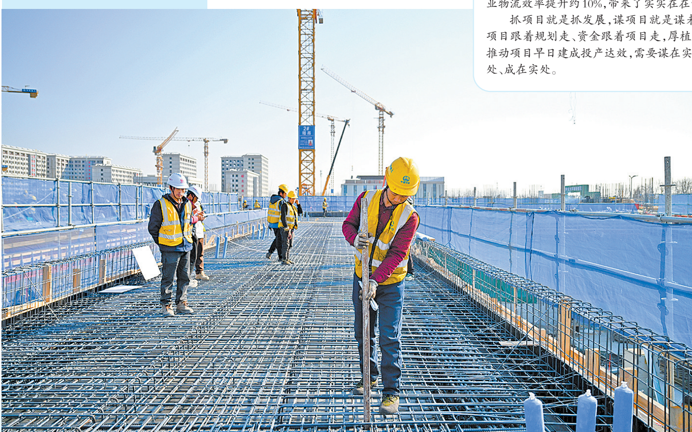
这是中铁建工集团工人在北京林业大学雄安校区建设现场施工。本版图片均为新华社发
